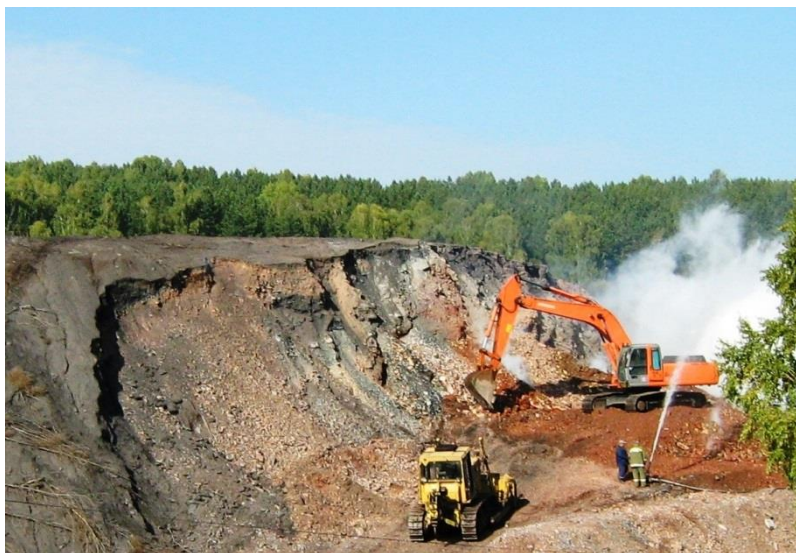
Рис. 2. Экскаваторная разборка горящего террикона (г. Осинники, Кузбасс, август 2012 г.)
